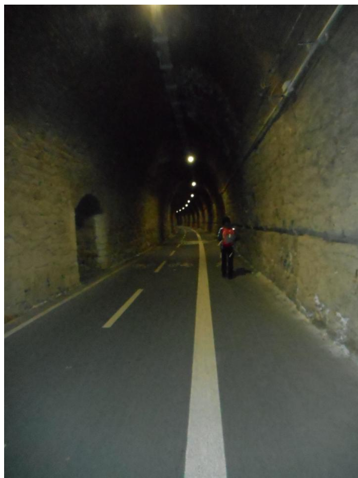
PISTA CICLO-PEDONALE DELLE GALLERIE "TRATTO FRAMURA – BONASSOLA"
